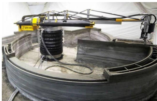
Figura 12: Robô construtor de casa com argamassa.[19]
