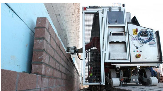
Figura 10 – Robô para assentamento de tijolos [17]
