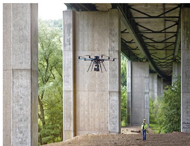
Figura 15: Inspeção por drones. [25]
